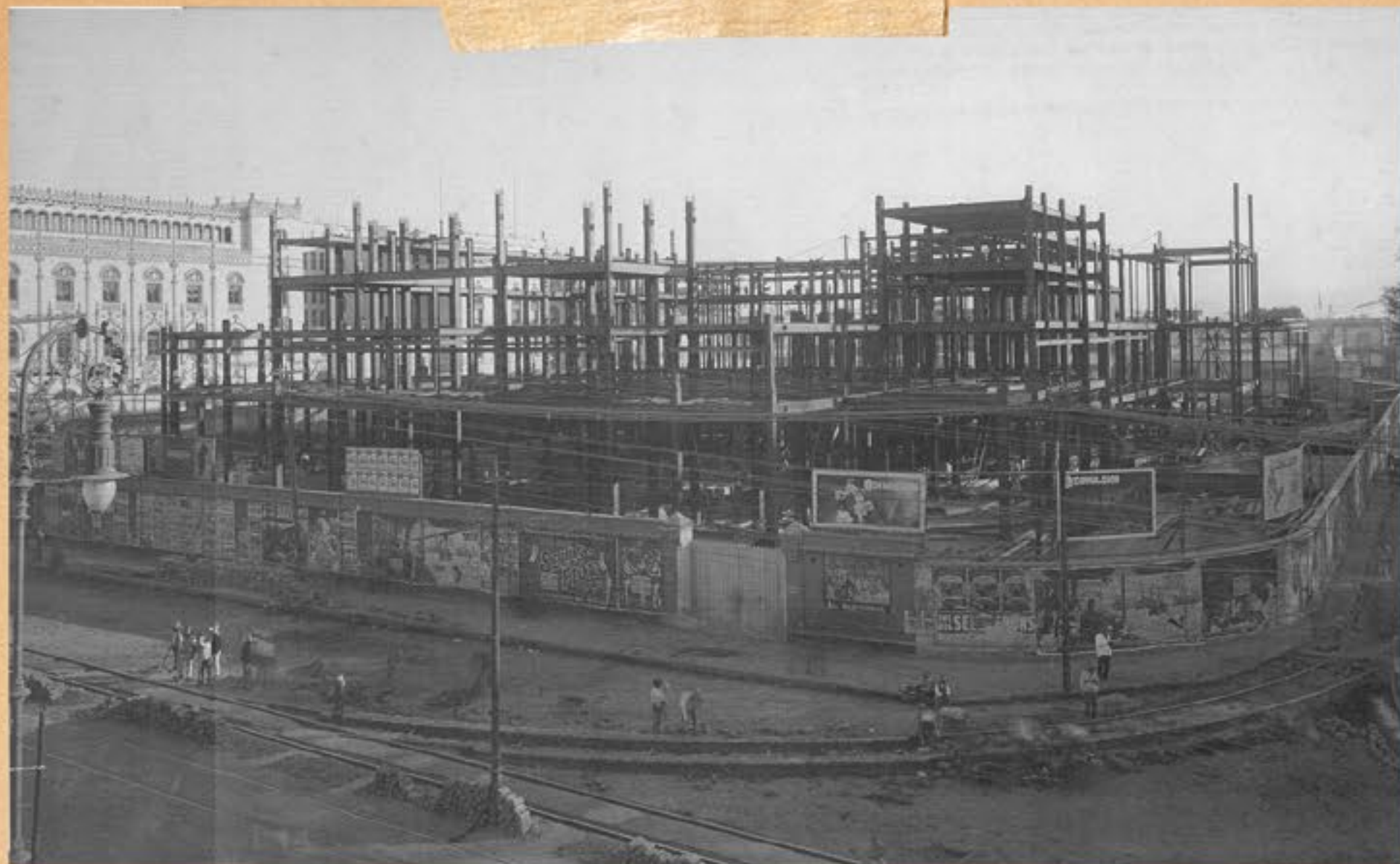
Guillermo Kahlo Parte construida del armazón (ángulo noreste), 1906 Fototeca de la Dirección de arquitectura y conservación del Patrimonio Artístico Inmueble, INBAL
